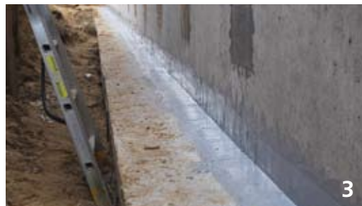
Foto's 1 t/m 3: FlexproofX 1 aanbrengen
