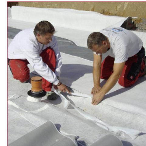
De niet-gecoate zijde zuigt een deel van het betonwater op, waardoor het beton zich aan het dichtingsmembraan vasthecht.
