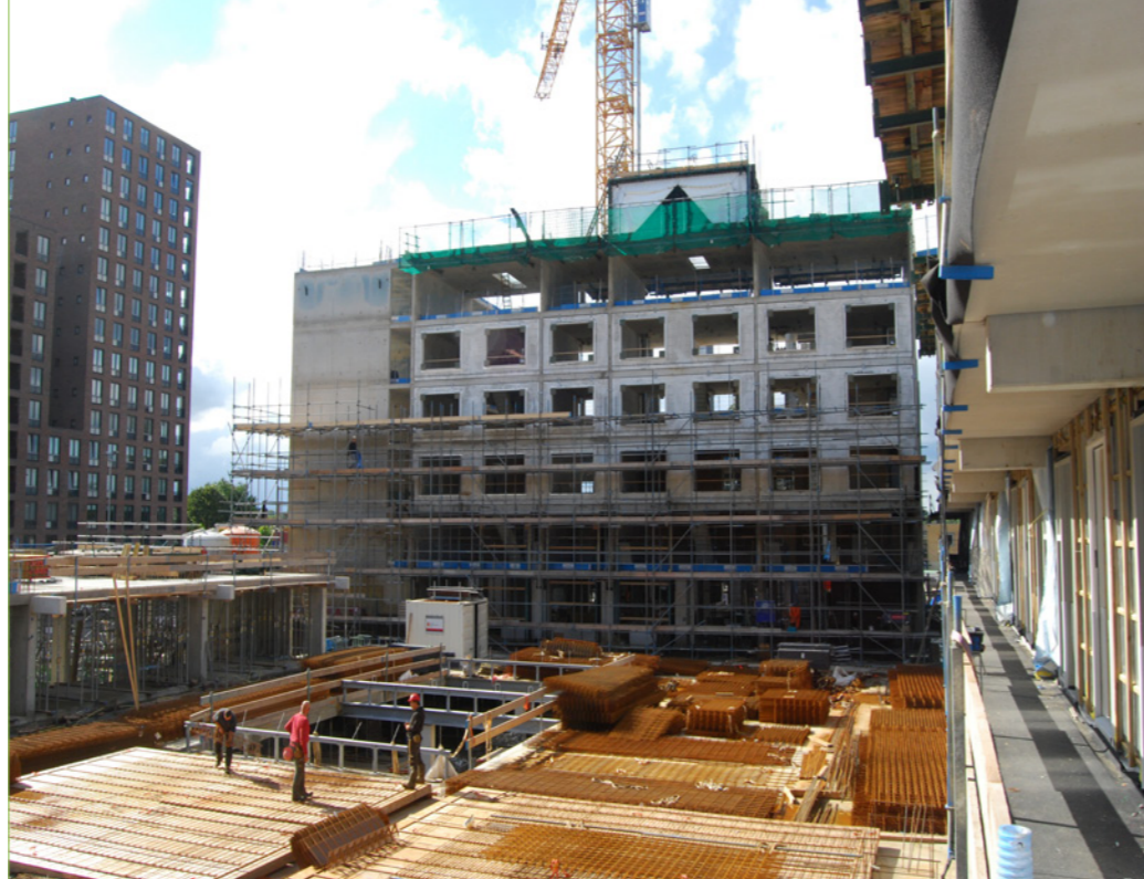
Overzicht deel project Tilburg Talent Square
