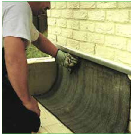
De dakbedekking wordt onder de neus van het LV profiel gewerkt
