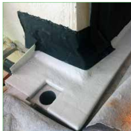
Maatwerk LV element in werk
