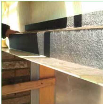
Loodervanger boven en om een geveldrager
