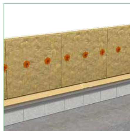
Als alle LV profielen zijn geplaatst kan de schuin op maat gezaagde isolatie worden aangebracht.
