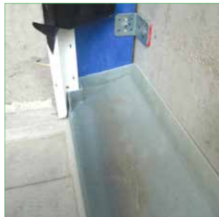
Compri LV 145 / 163 maatwerk geplaatst
