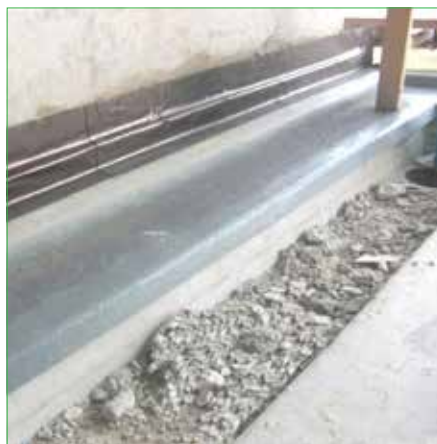
Geplaatst en luchtdicht afgeplakt
