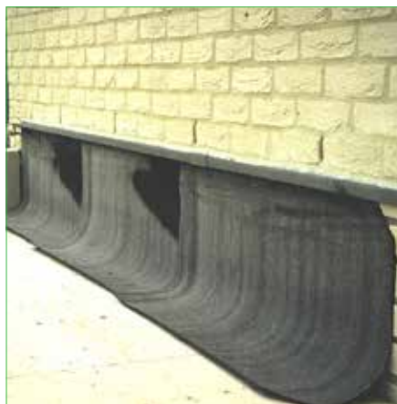
Eindsituatie met aangebracht dakbedekking.
