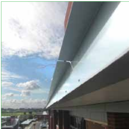
Polyester dakrand afwerking
