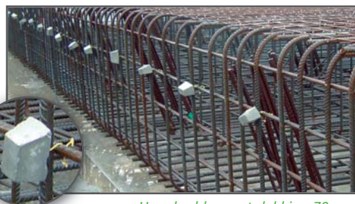
Hunebedden met dekking 70 mm
