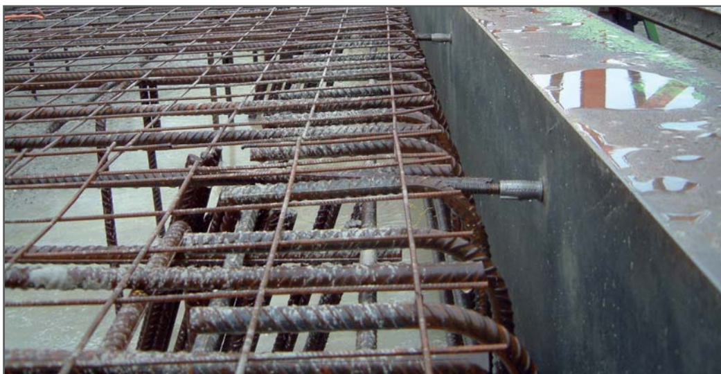
Trunic aan achterzijde vloer L-element
