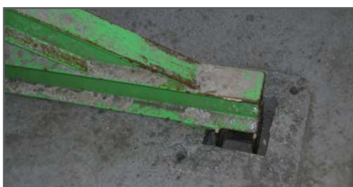
Door betontegels eenvoudig fixeren bekisting op werkvloer
