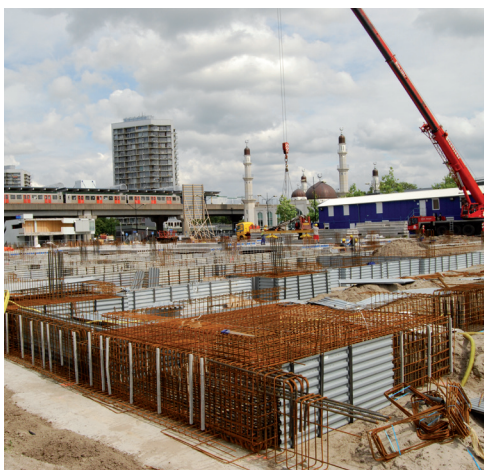
Foto onder: Overzicht deel bouwput
