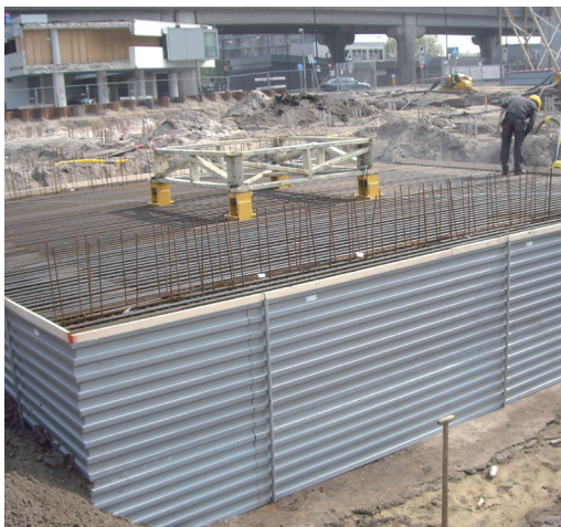
Foto onder: ESB-bekisting kraanpoer
