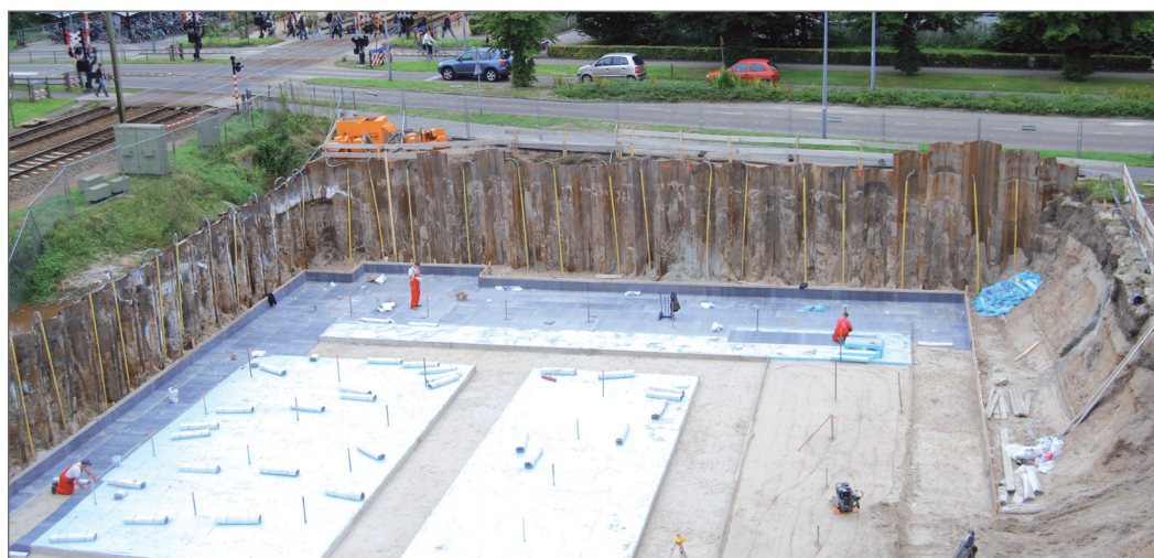
Overzicht deel bouwput
