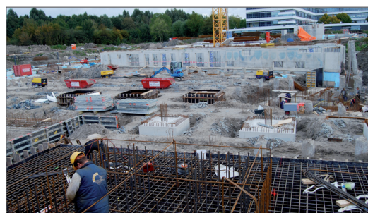
Overzicht deel bouwput
