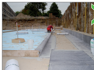
Voltex aanbrengen op het zandpakket
