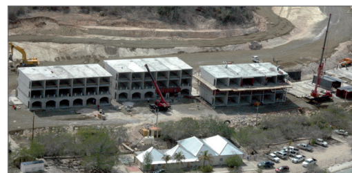
Het hotel in aanbouw
