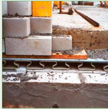
Vibrex lengte-dempbeugels onder gemetselde muur.
