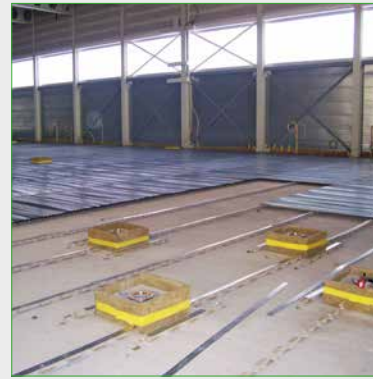
Vibrex lengte-dempbeugels voor zwevende dekvloer.
