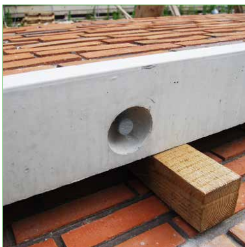
Prefab met Hakron-Terwa hijsvoorziening (Kogelkopanker)
