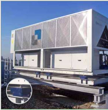
Airconditioning op dubbel veersysteem; Mafund en Trillingdemper type FN-vierkant B.
