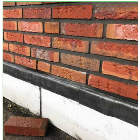
Na het metselen
