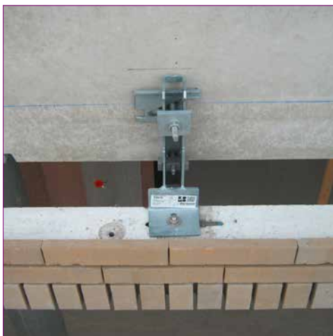
De stelschroef van de Multi-D geveldrager is ideaal om onregelmatigheden in het betonwerk op te vangen.
