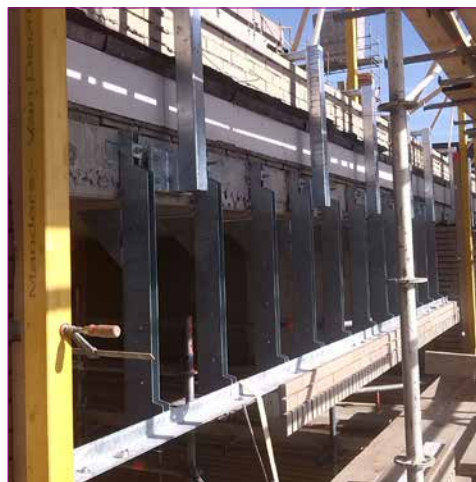
De stelschroef van de Multi-D geveldrager is ideaal om onregelmatigheden in het betonwerk op te vangen.
