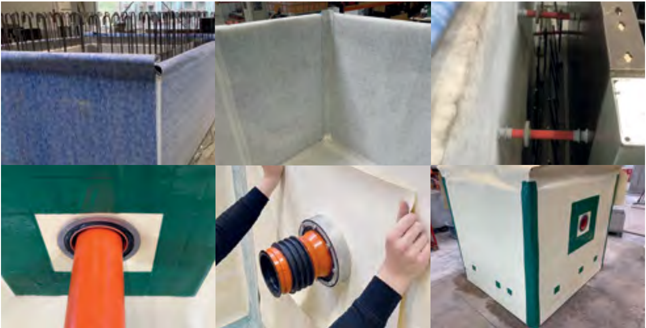
KRASO® Pompput - beton - met systeemconforme aansluiting op betonafdichtingsmembranen buisaansluiting met systeemconforme aansluiting door KRASO® Type FBV-FR
