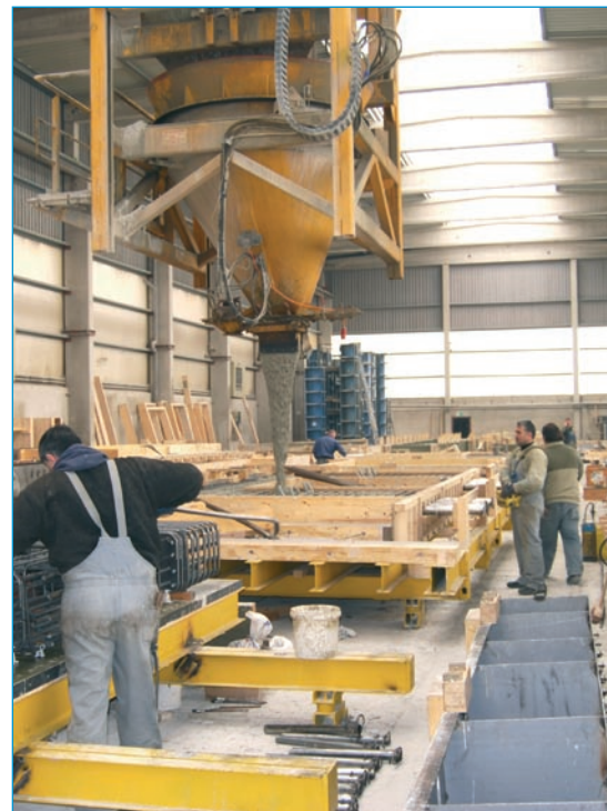
Beton storten in één van de fabriekshallen
