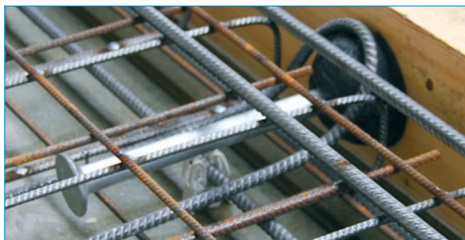
T-slotanker ingebouwd in mal
