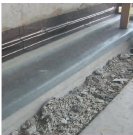
Geplaatst en luchtdicht afgeplakt
