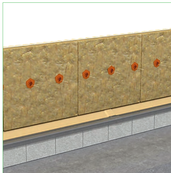
Als alle LV profielen zijn geplaatst kan de op maat gezaagde (schuin) isolatie worden aangebracht.
