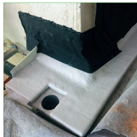
Maatwerk LV element in werk
