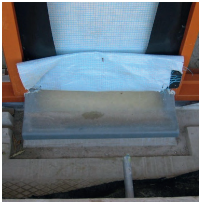
Geplaatste LV penant element
