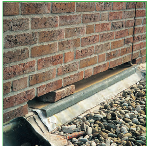
Afgebrachte Compri LVR profiel wordt aangewerkt. Overlap blijft vrij.
