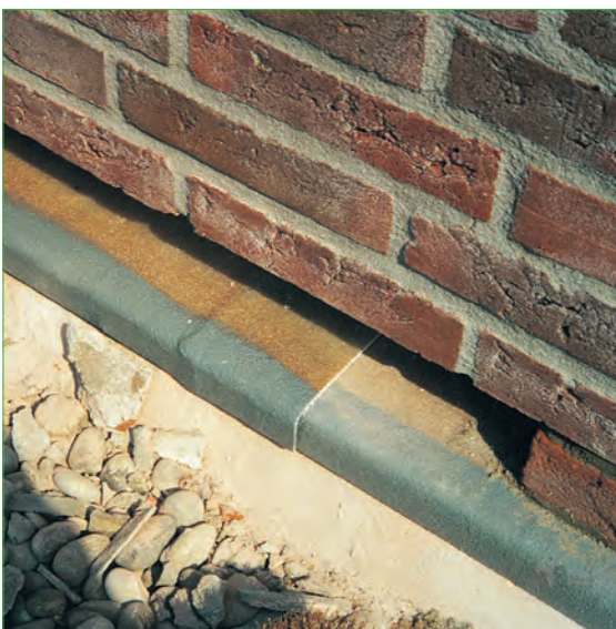
De volgende 1000 mm wordt vrijgemaakt en het tweede LVR profiel wordt aangebracht. Twee rillen Hechtkit 2000 aanbrengen in het facet voor het dichtn van de overlap (zie ook montage LV profiel).
