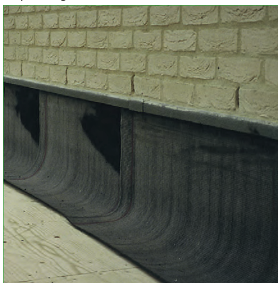
Eindsituatie met aangebracht dakbedekking.
