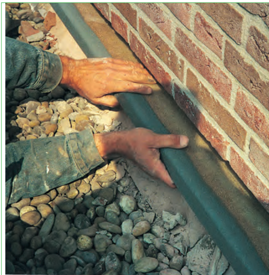
Onderste laag stenen wordt over 1000 mm en het Compri LVR profiel wordt ingebracht.
