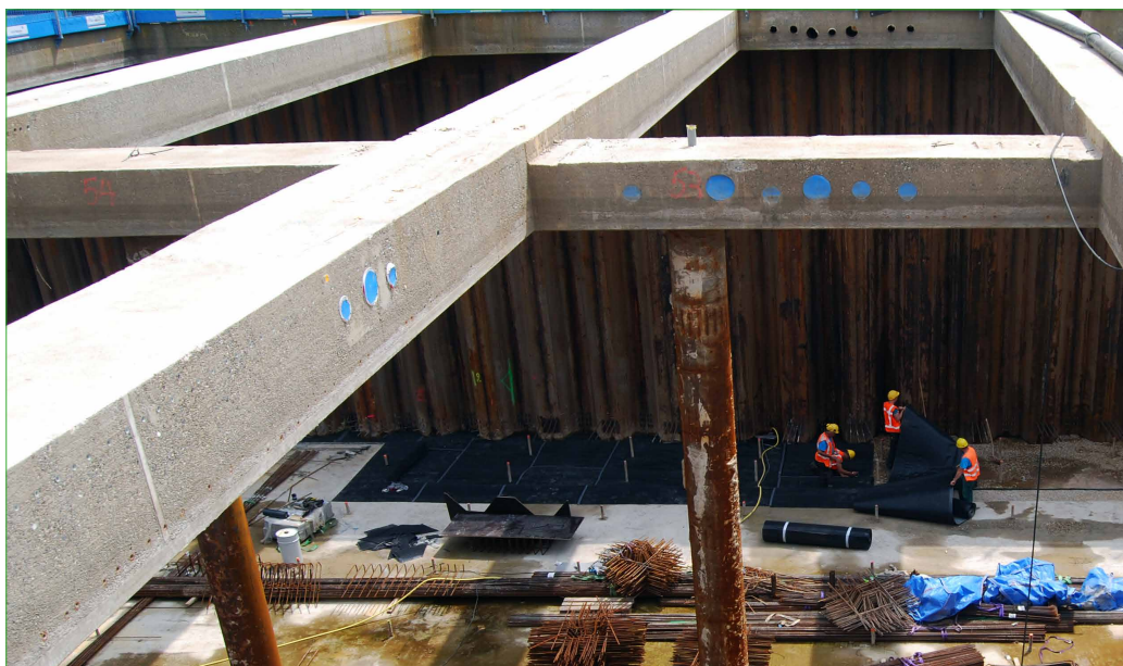
Stempelraam, onderin de bouwput wordt Drain Tec noppenfolie aangebracht
