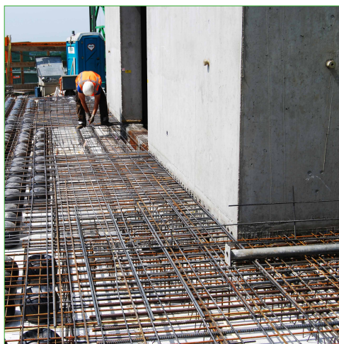
Konnectie-einden TSE in vloer en klimconus in kern
