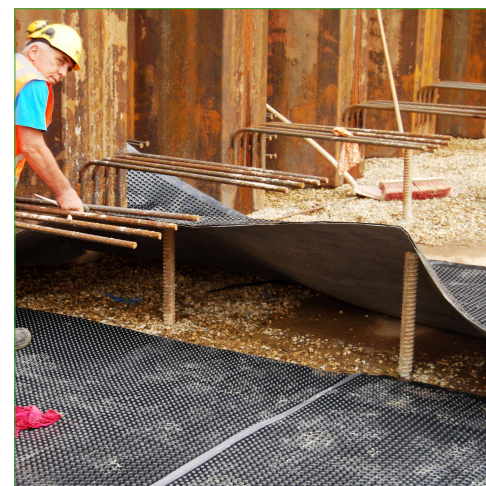
Drain Tec noppenfolie aanbrengen
