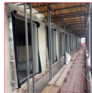
Stelkozijnen aan de buitenzijde afgeplakt met Butylband Alu
