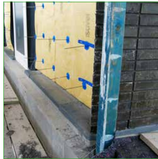
Compri LV rechts onder metselwerk en links geplaatst
