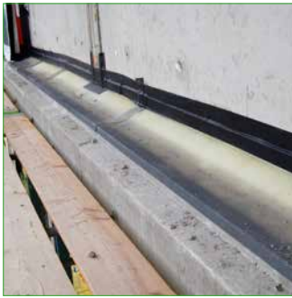
Compri LV aangebracht
