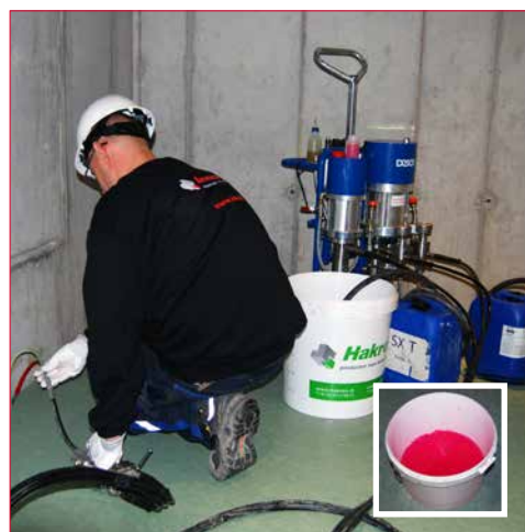
Gel-injectie met behulp van 3D-injectiepomp
